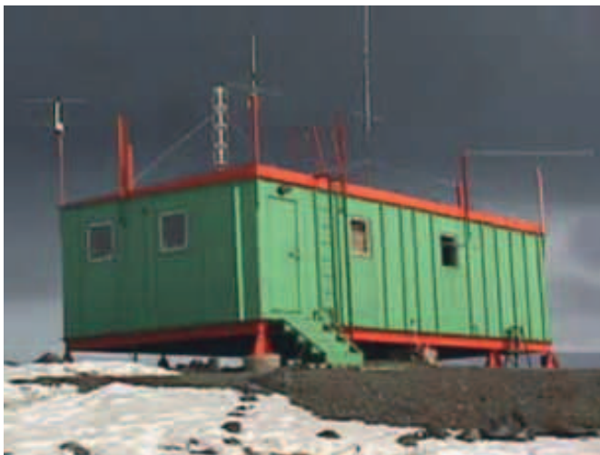
Figura 1: Módulo de Meteorologia da EACF. Notar as antenas externas de recepção e envio de dados e informações, criando ambiente de trabalho não convencional.
