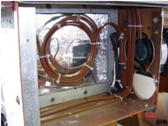
Foto 8 - Caixas com disjuntores elétricos para o sistema CAM1: 2 para câmera e 2 para ventoinha e aquecimento (cx da esq.); 1 para turbina e 2 para cinta térmica (cx da direita).
