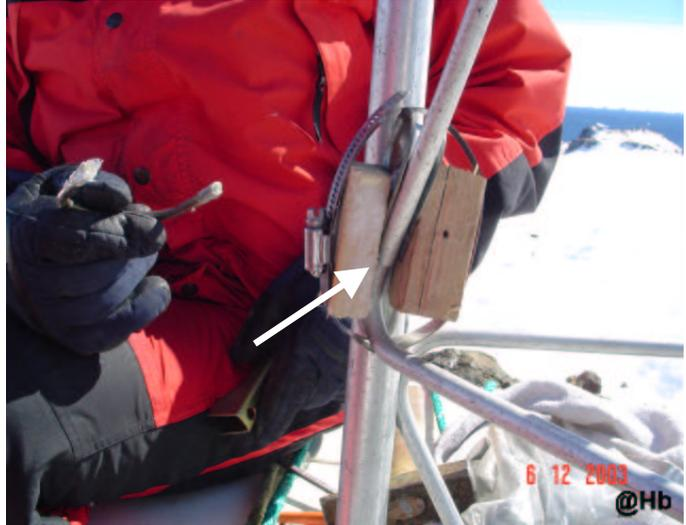
Foto 6 - Adaptação de reforço na treliça quebrada da Torre.
