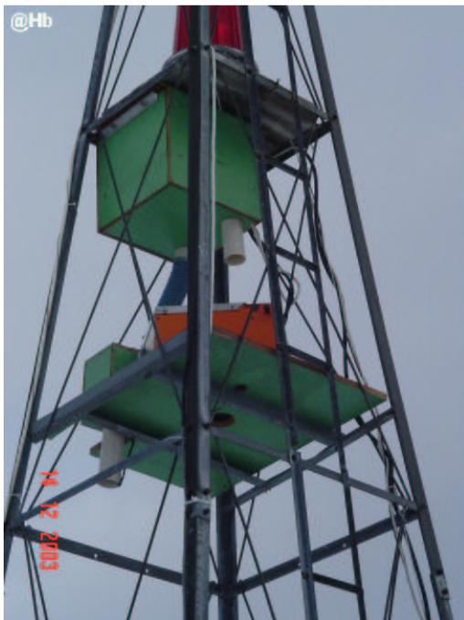
Foto 1 - Nova instalação do conjunto CAM1. Na parte inferior tampo de madeira e caixa metálica com os equipamentos. Na parte superior caixotão com sistema de turbina para ventilação forçada.
